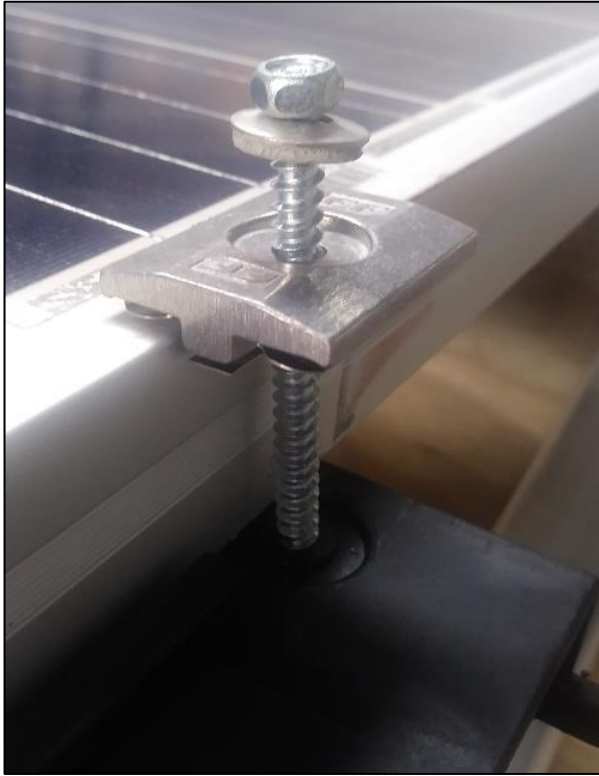
Figuur 3: Gebruik van universele middenklem met vereffening
