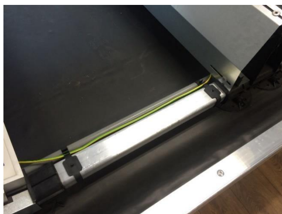
Figuur 10: Meeraderige kabel bevestigd met kabelclip (100-7041)
