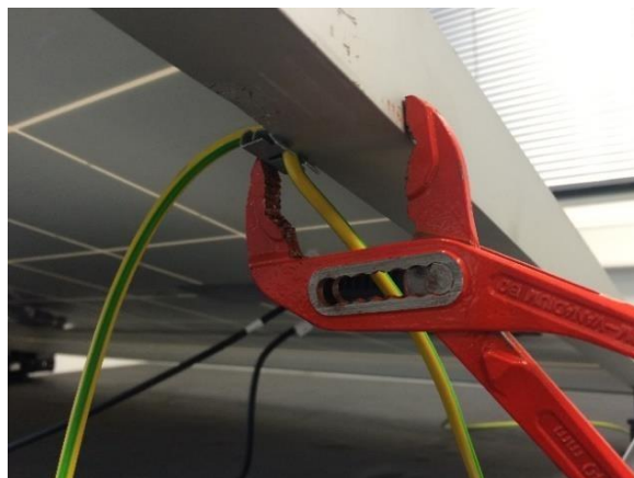
Figuur 7: Bevestigen van aardingsklem
