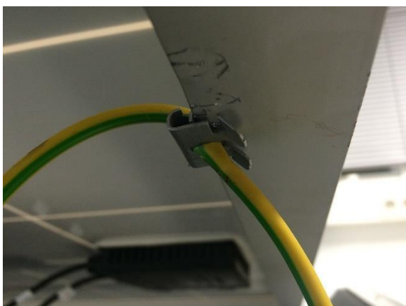
Figuur 8: Aardingsklem detail
